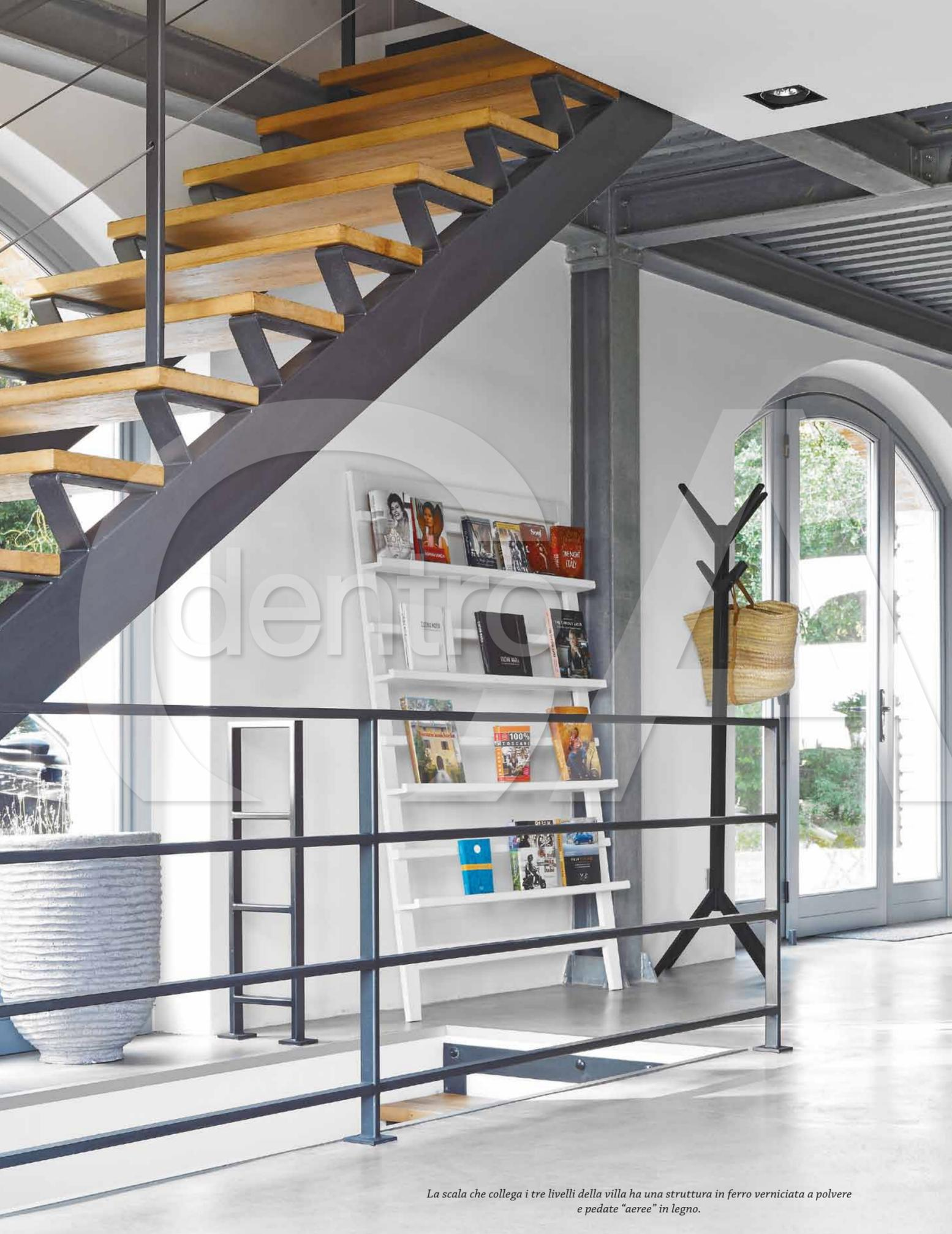
*La scala che collega i tre livelli della villa ha una struttura in ferro verniciata a polvere e pedate "aeree" in legno.*
